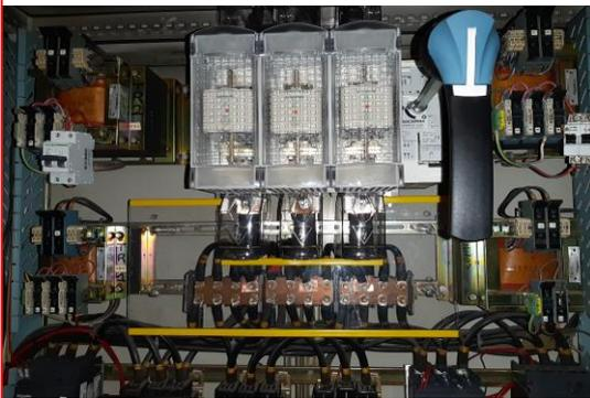
**Faits** : Changement d'un inter-sectionneur dans une armoire client existante. En passant **rapidement** sa main dans le châssis de l'armoire (zone sans visibilité), un opérateur s'est **coupé** la paume de la **main** avec une barre de ferraille non-ébavurée.
