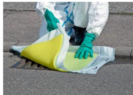
Obturation préventive d'une plaque d'égout
