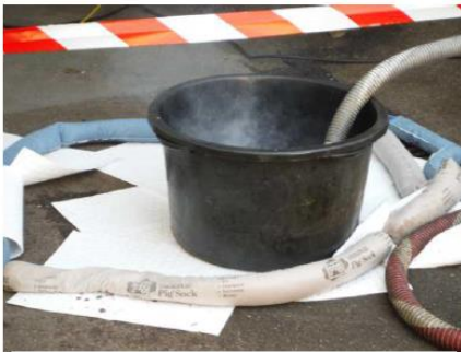
Mise en place préventive d'un boudin absorbant autour d'une zone à risque d'épanchement
