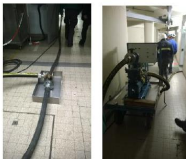
Création de bacs étanches de rétention « sur mesure »
