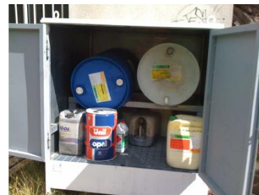
Bac de rétention couvert et fermé
