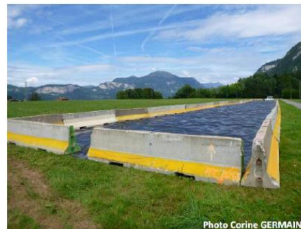
Dispositif étanche au sol pour accueillir un camion-citerne
