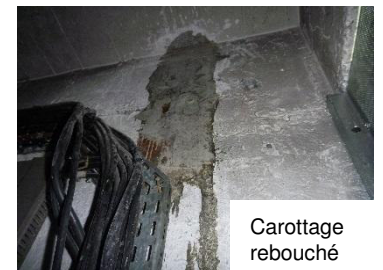
Coupure de câbles lors du carottage
