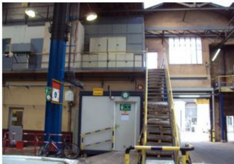
Baignoire de sulfate de magnésie au Nord de la travée centre de de l'atelier
